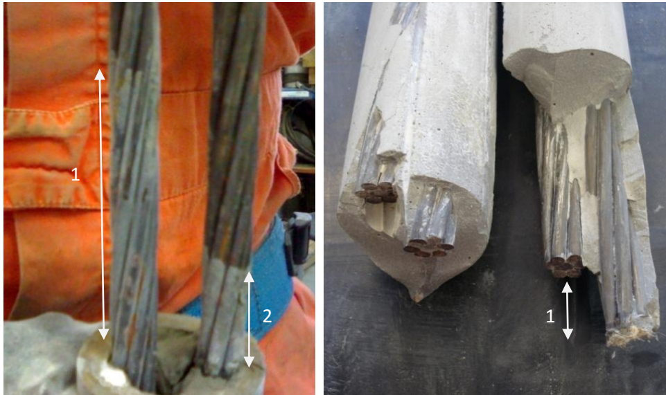
Figura 4.25 - Deslocamentos dos cabos após a tracção: 1 - deslocamento do cabo traccionado; 2 - Deslocamento do cabo não traccionado.
