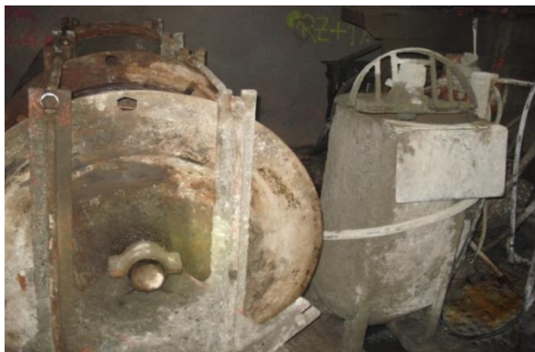
Figura 4.7 - Bobina com cabos e tambor de calda de cimento.
