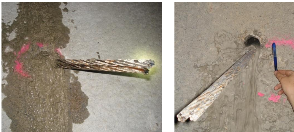
Figura 4.6 - Sistema de cabos aplicado: à esquerda, logo após a colocação; à direita, aspecto anterior à operação de traccionamento.
