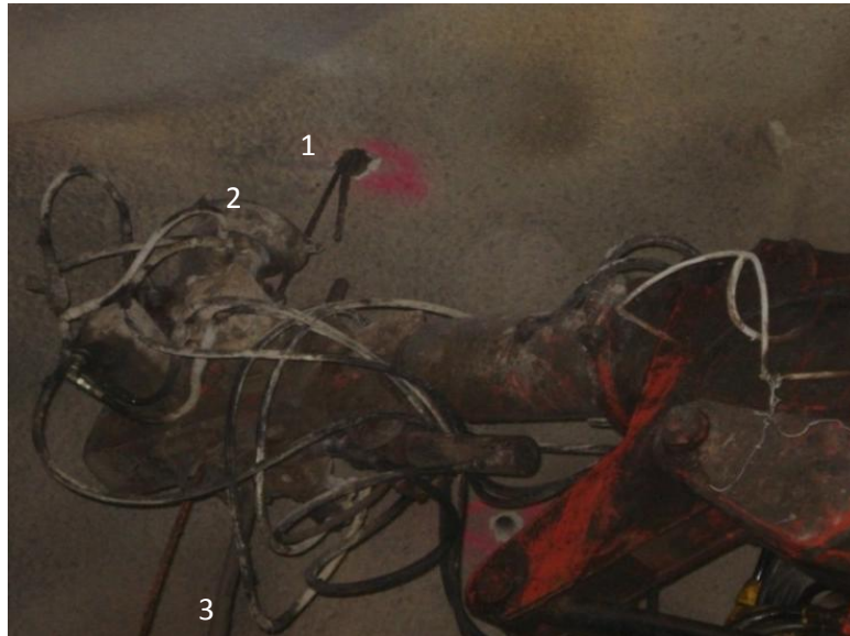
Figura 4.8 - Colocação de cabos: 1- furo com cabos; 2- rebarbadora; 3- tubo de injeção de calda de cimento.
