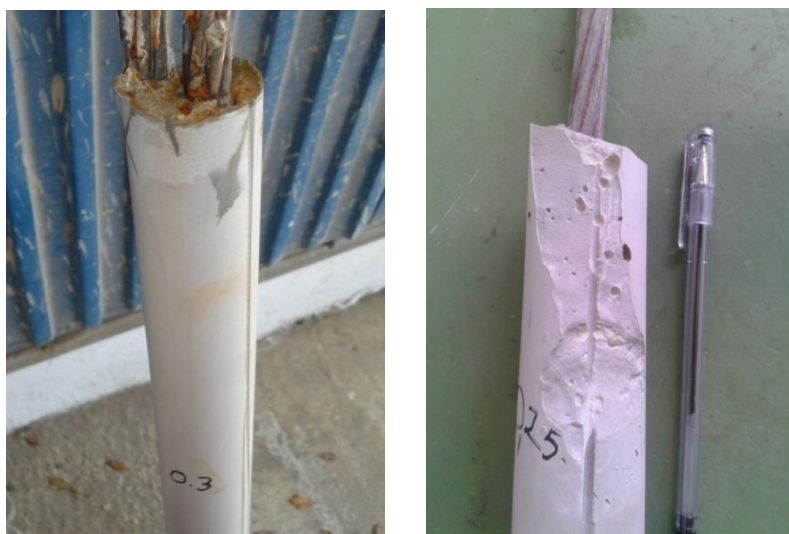
Figura 4.27 - Verificação de vazios: Superfície lisa, sem vazios (esq.); Vazios interiores de pequenas dimensões (dir.).
